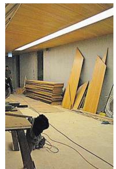
Im Foyer wird noch gezimmert
